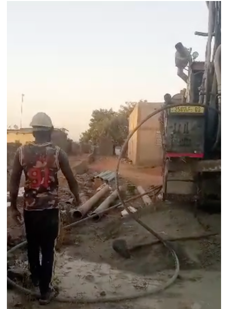
Burkina - Arbeit an der Bohrstelle
