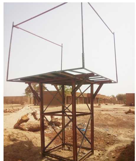
Burkina – Gerüst für den Wassertank
