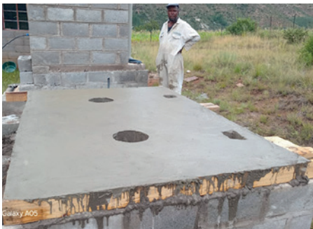
Lesotho - Fundament, Ecosan-Toiletten
