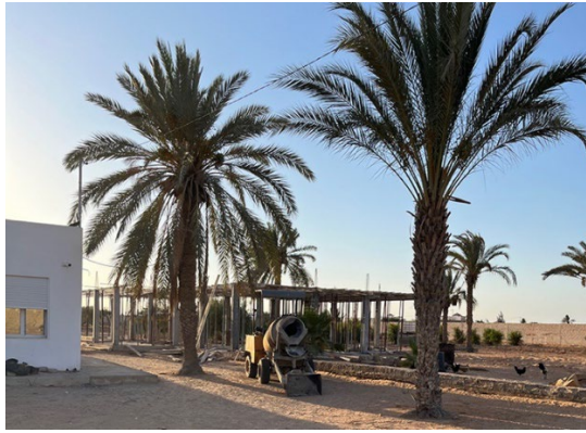
Rohbau für Schulungs- und Veranstaltungsraum
